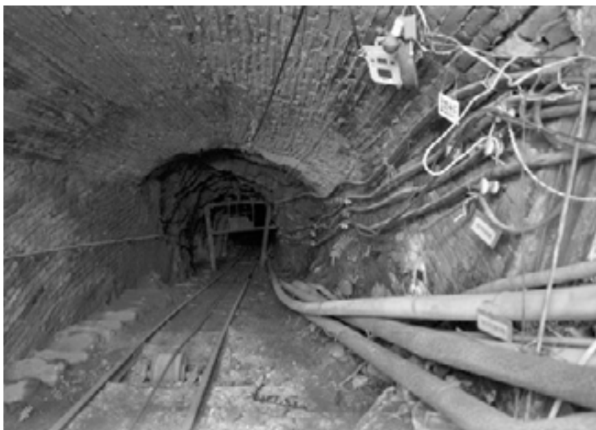
湖北黄石，小矿被关停后，有的矿井的矿口，都没来得及封闭
