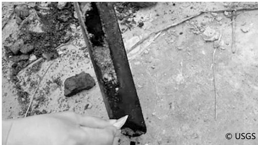
周建刚用钢管打入地下 4 米，混凝土下，墨黑的渣土像浸过煤油一样，散发着浓重的农药味
