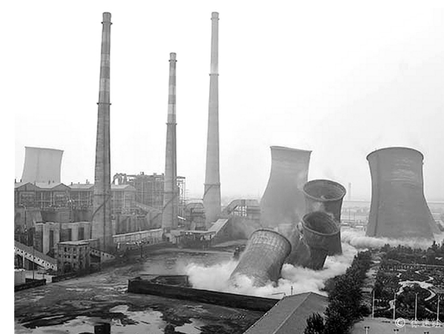
山东省某集团的7台总装机容量68万千瓦的燃煤机组集中爆破（2015年8月11日摄）
