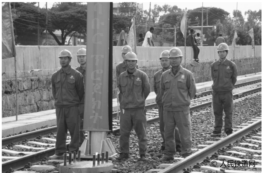
当地时间2014年4月13日上午8时，由中国中铁承建的埃塞俄比亚轻轨工程四电专业施工迎来了一个重大工序节点，埃塞轻轨“电气化第一杆”顺利完成了组立
